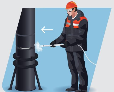
10. При наращивании, продуй соединение при зазоре (5-7 мм) сжатым воздухом! Продолжай свинчивание до полного устранения зазора.
